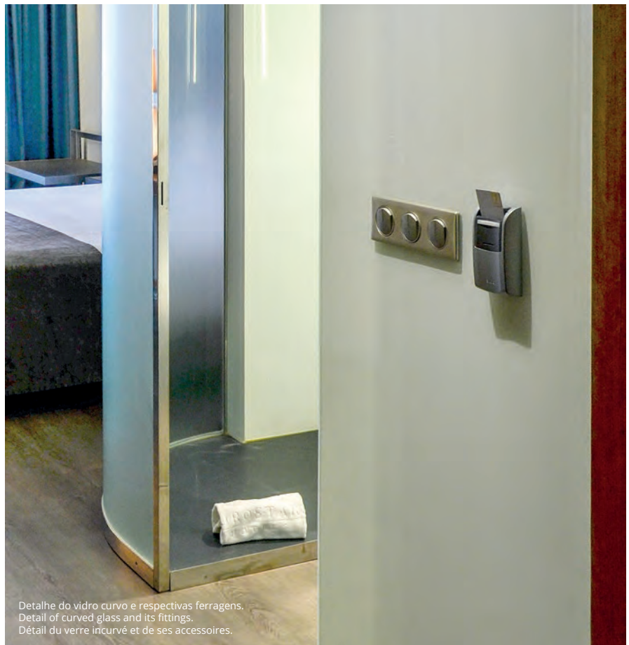
Peças porta pivotante PGR-456, 3101, PGR-466, 3132 especiais e fechadura FEC-688. PGR-456, 3101, PGR-466, 3132 pivot door parts and lock FEC-688. PGR-456, 3101, PGR-466, 3132 parties de porte pivotantes et serrure FEC-688.
