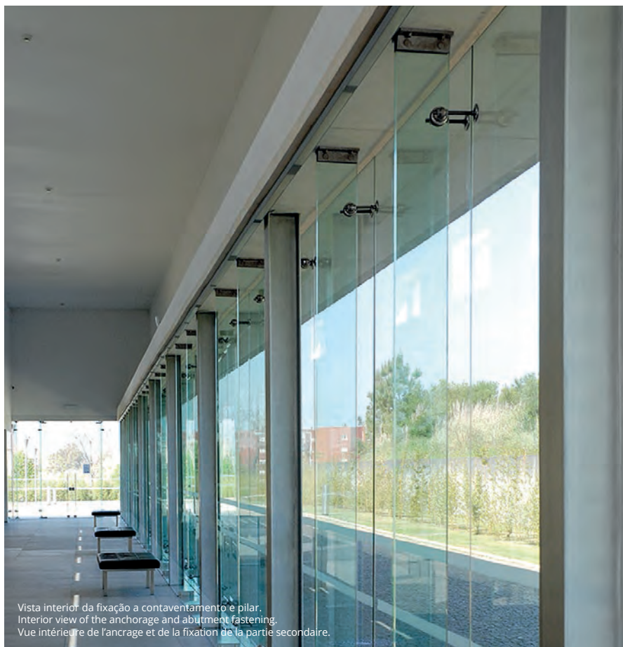
Componentes do sistema agrafado para suporte em contraventamento de vidro. Components of the stapled system for support in glass bracing. Composants du système agrafé pour soutenir dans les contreventements en verre.
