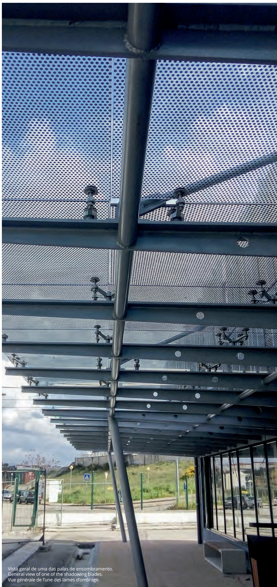
Imagem do conjunto com aranha de 4 pernas SAG-1004 e rótulas SAG-1011. Set image with 4 legs spider SAG-1004 and SAG-1011 kneecaps. Image avec des araignées de 4 pattes SAG-1004 et les rotules SAG-1011.
