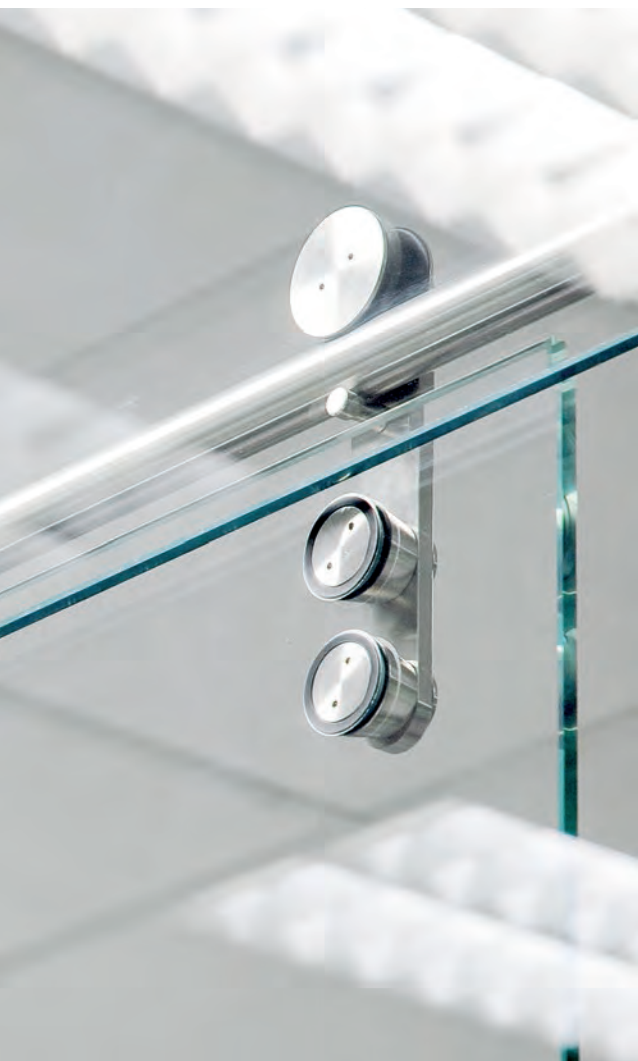
Sistemas de porta de correr PCR-7135 na sede da AFCAMÕES. PCR-7135 sliding door systems at AFCAMÕES headquarters. Systèmes de porte coulissante PCR-7135 au siège de AFCAMÕES.
