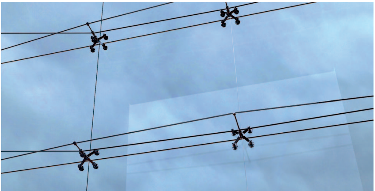
Aplicação de cabos estruturais.
