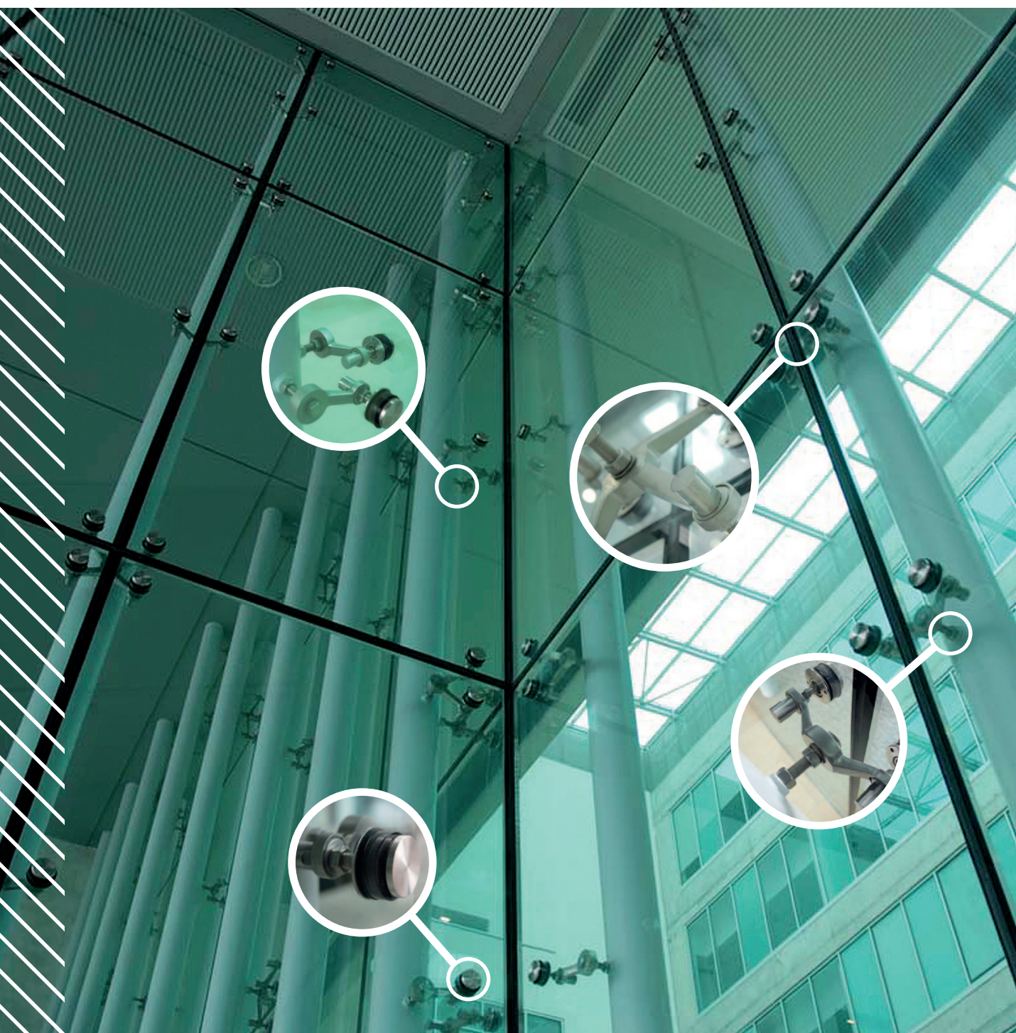
Sistema de fachada agrafada - Hospital de Braga.
